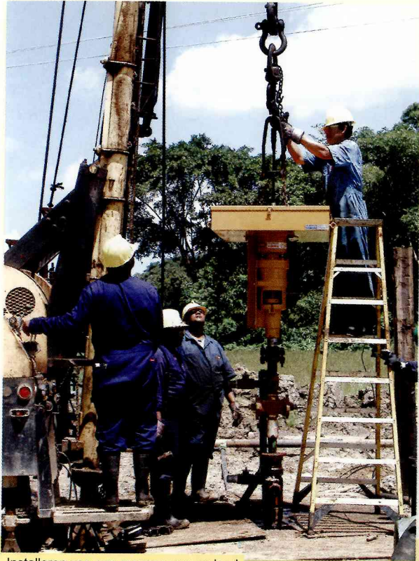
Installeren van een moynopomp op land
