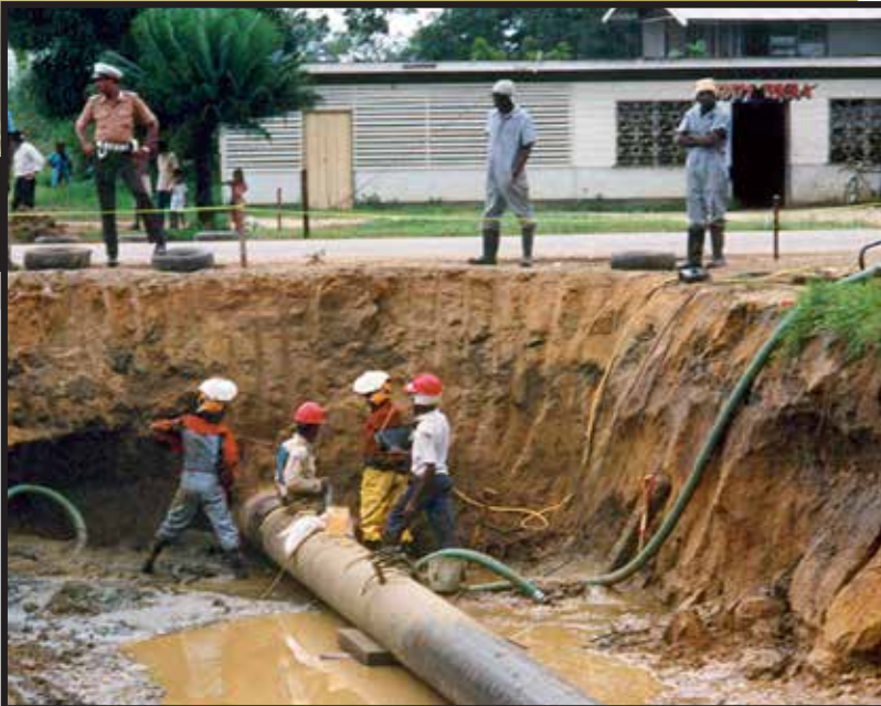
1992 Aanleg van de pijpleiding Saramacca-Tout Lui Faut. Construction of the Saramacca-Tout Lui Faut pipeline.
