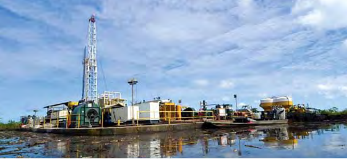
Olieboring in het Tambaredjo Noordwest veld.
