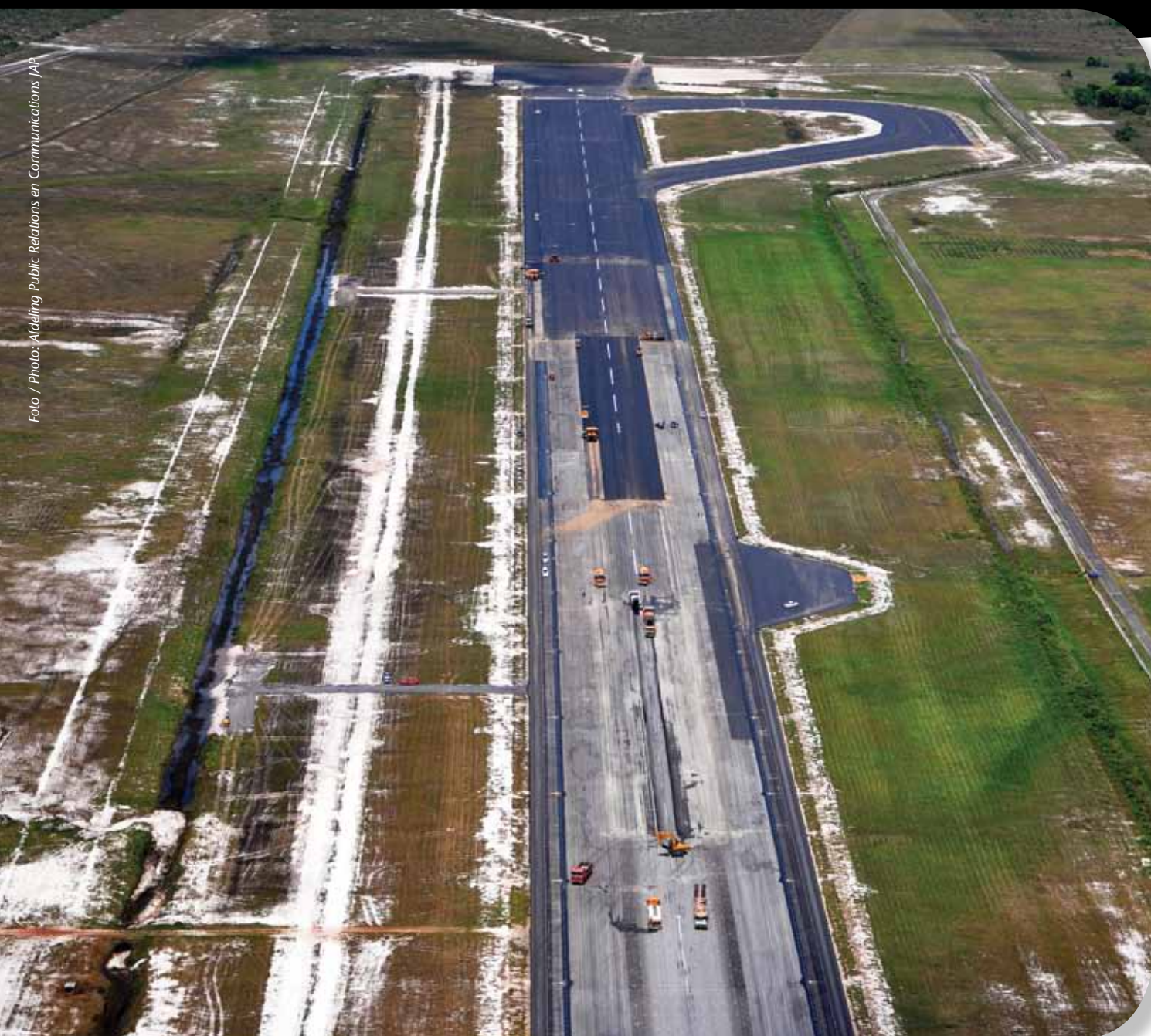
Asfalteringswerkzaamheden op de landingsbaan van Johan Adolf Pengel International Airport.
