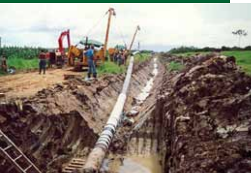
De pijpen zijn in een sleuf van anderhalve meter diep geplaatst.
