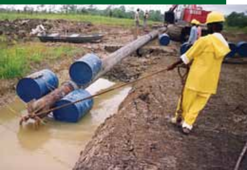
Er werden vaten op de buizen vastgemaakt, zodat deze bleven drijven.
