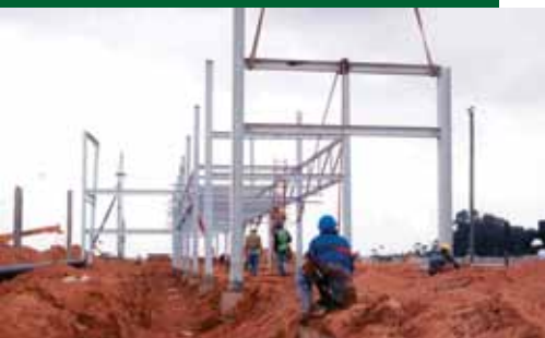
Het prille begin van de constructiewerkzaamheden van de raffinaderij.
