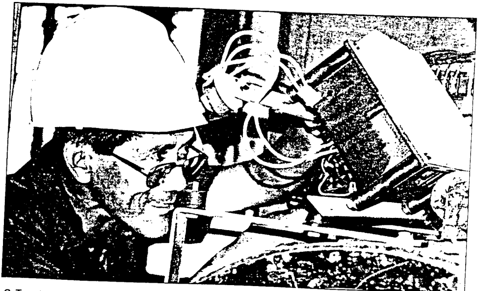
G. Tamat van de afdeling Utility is hier bezig met een electrical servicebeurt aan een generator
