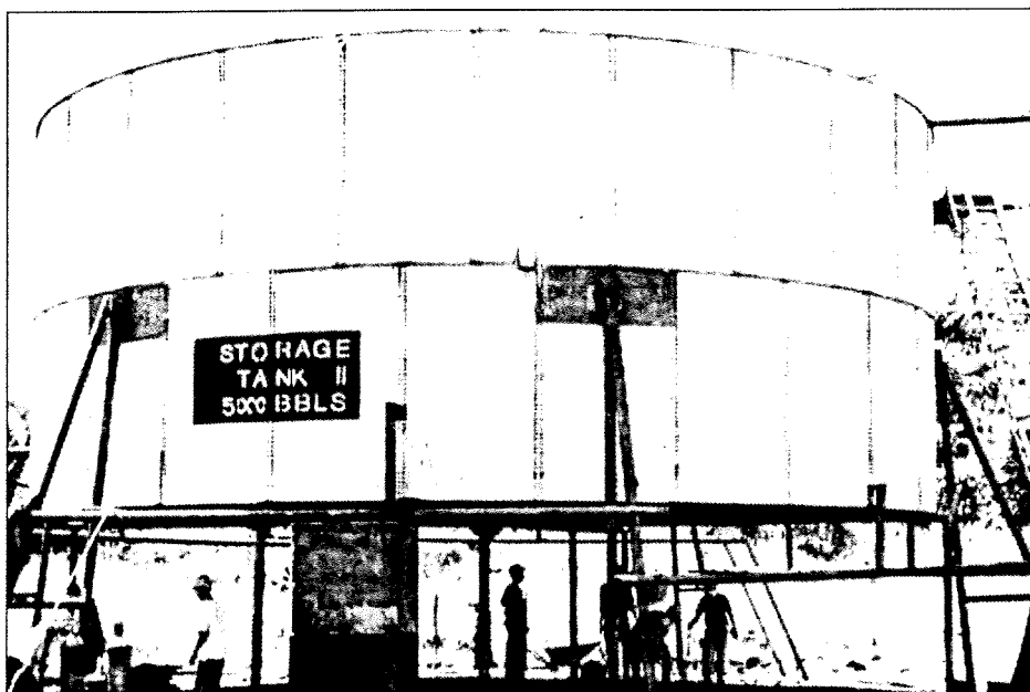
De opslagtank werd 10 cm omhoog getild, waarna de onderste platen gedemonteerd konden worden en de tank van een nieuwe bodem en een gedeeltelijke zijwand kon worden voorzien
