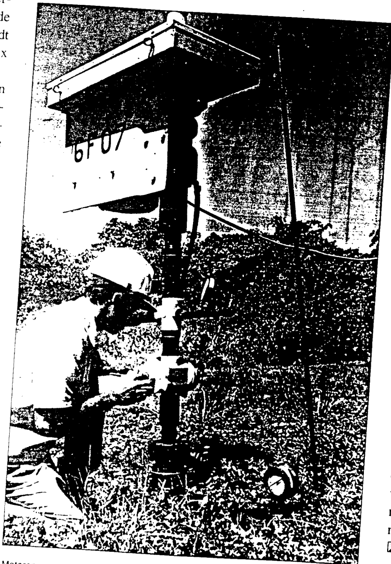
Meteropname bij een Moynopomp met pressure relief valve
