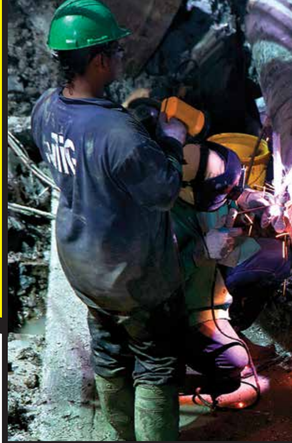
De aansluiting van de nieuwe rivierverbinding op de Saramacca-Tout Lui Faut pijpleiding.
