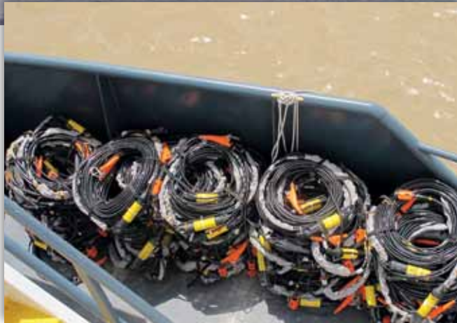
Deze kabels worden op de zeebodem gelegd.
