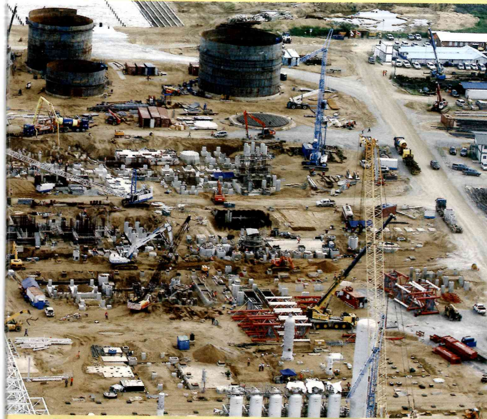
De constructiewerkzaamheden zijn in volle gang.
