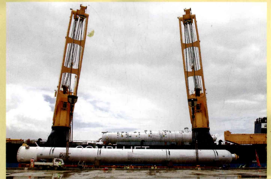
De hydrocracker reactor (op de voorgrond) en de vacuümtoren zijn individueel de zwaarste fabrieksonderdelen in de nieuwe raffinaderij.
