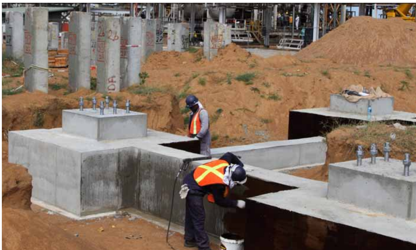
Construction site at Tout Lui Faut.
