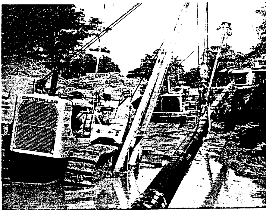
De side-booms zetten de aan elkaar gelaste pijpen op hun plaats
