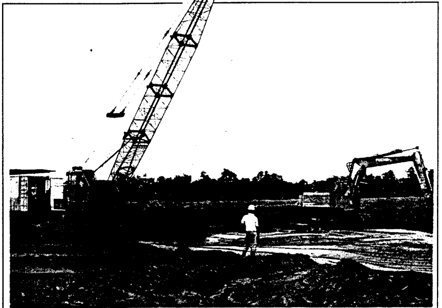
Rivierzand wordt samen met water opgespoten op het raffinaderij terrein te Tout Lui Faut
