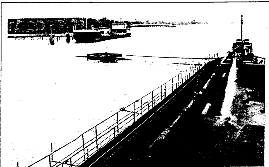
Het lossen van rivierzand uit de hopper zuiger "GEMMA" om vervolgens verpompt te worden via de drijvende- en landbuizen naar het raffinaderijterrein
