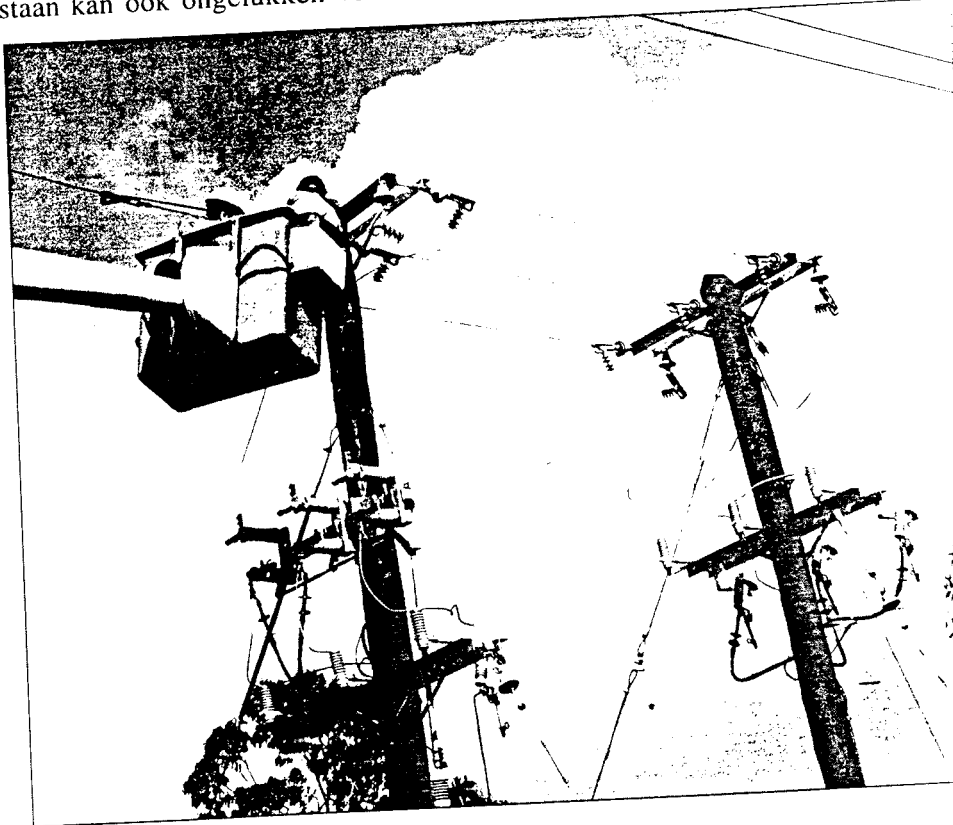
Werkzaamheden aan een electriciteitsmast
