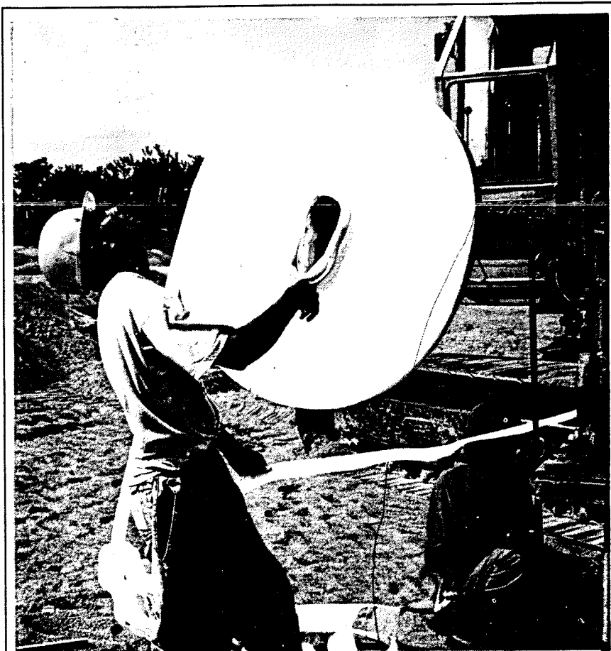
Het installeren van een colbond drain voor de heistelling
