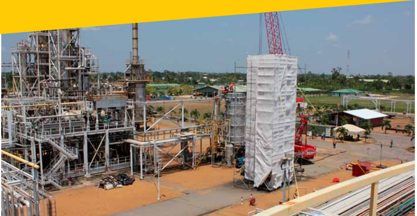
Het installeren van de nieuwe heater.
