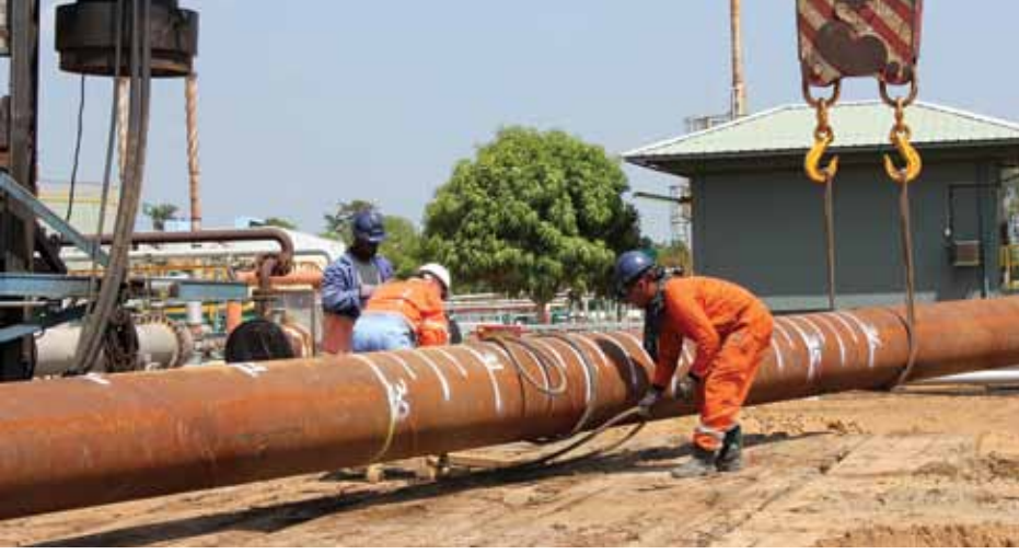
Medewerkers brengen de paal in stelling om geheid te worden.
