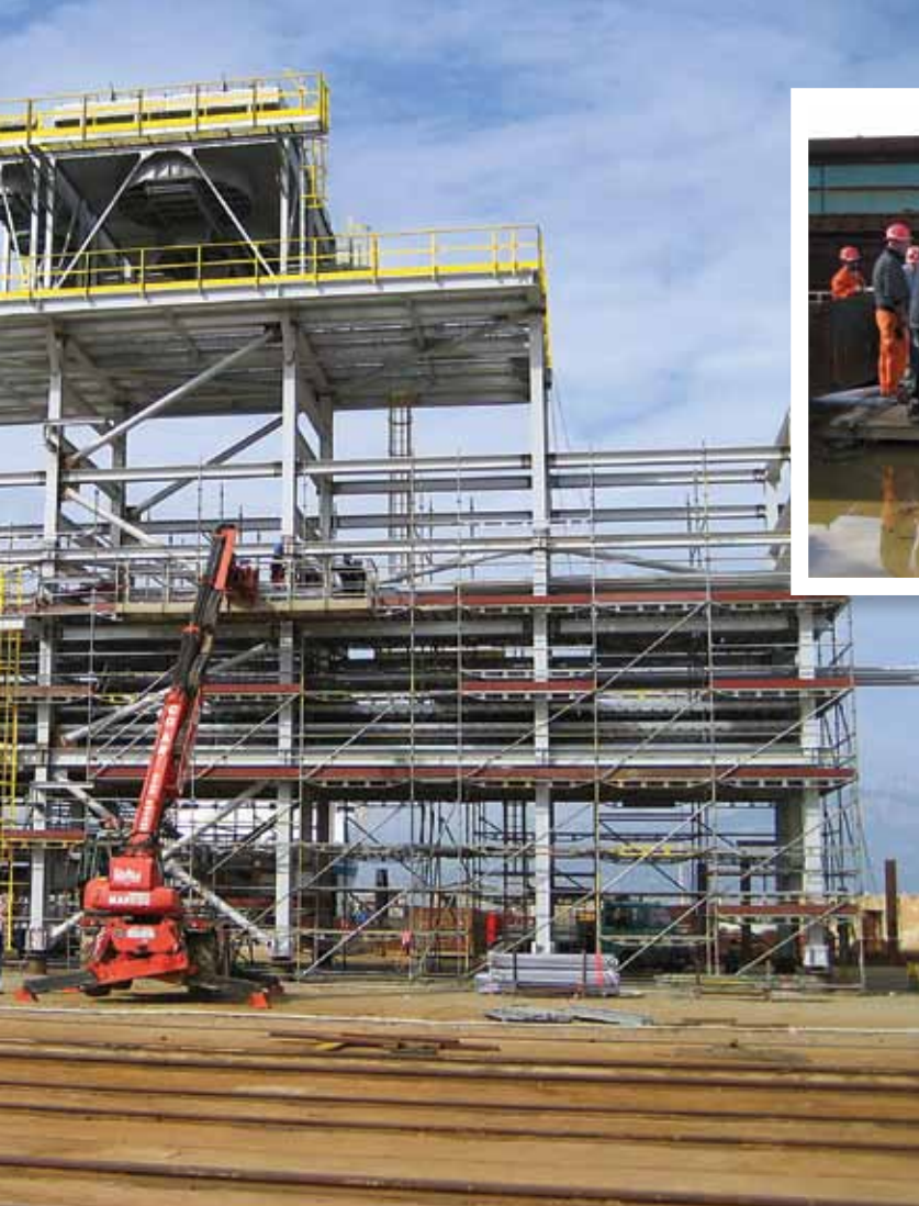
Een Pre-Assembled Rack (PAR): een stalen raamwerk waarin pijpen, bekabeling en luchtkoelers zijn geïnstalleerd. In Suriname worden de losse PARs met elkaar verbonden.
