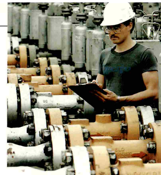
Controlewerkzaamheden bij binnenkomende gasleidingen.
