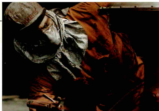
Spuitwerkzaamheden bij de renovatie van een cluster in Groningen.
