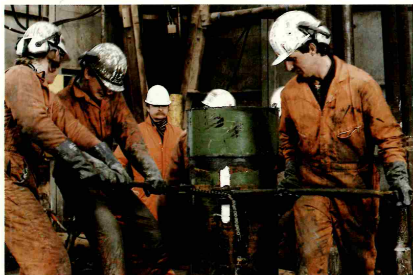
Het inbrengen van de casing, de bekledingsbuizen die met cement aan de boorgatwand bevestigd worden.
