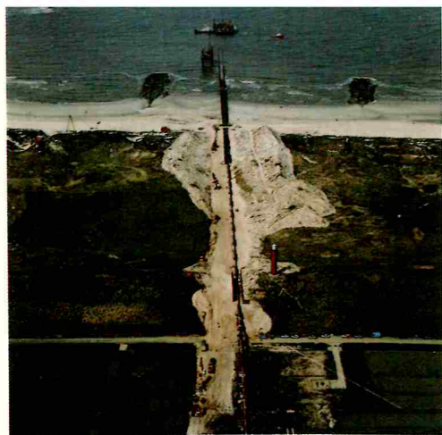
Het leggen van de pijpleiding bij Callantssoog, in 1983. Nu is het duin allang weer volledig hersteld.
