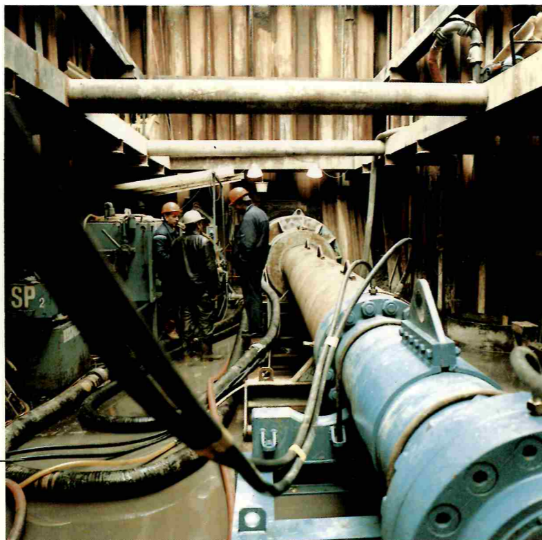
Werkzaamheden aan een pijpleiding, vele meters onder het straatoppervlak.
