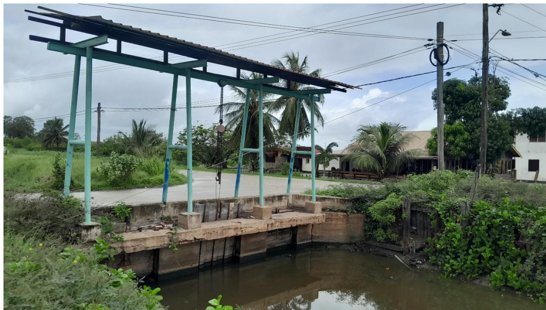
Foto 3: De sluis bij het kanaal (Trens Henry Fernandesweg)
