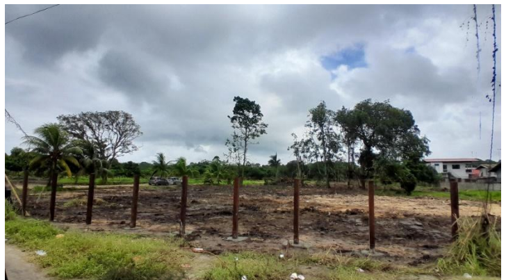
Foto 16: Grondverzetactiviteiten aan de Kwattaweg
