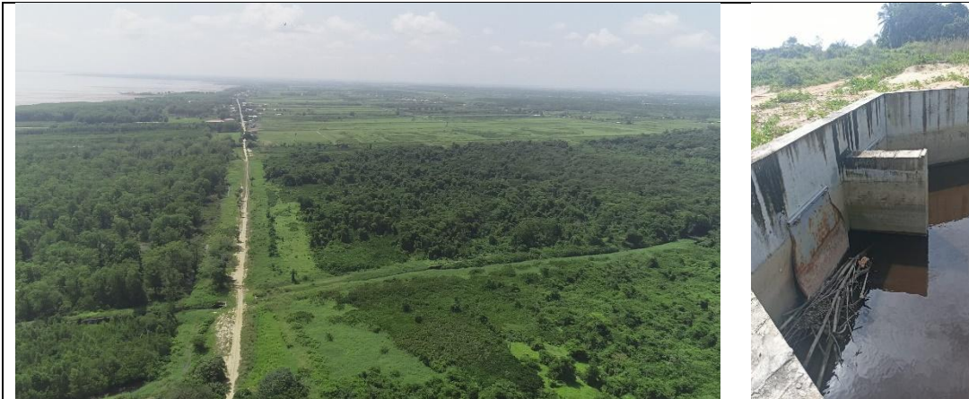
Foto 2: Kanaal met klep duiker bij de waterweg langs de Oedayrajsingh Varmaweg (zand gedeelte)
